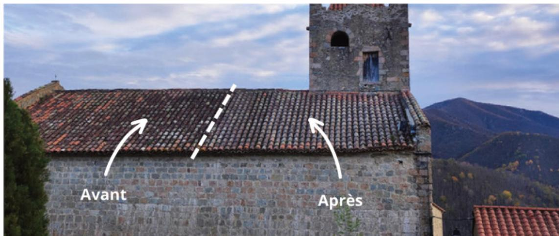
Après des dégradations dues aux intempéries, plusieurs tuiles se sont détachées. Après consultation des services de la DRAC, les travaux se sont orientés sur la dévégétalisation de toute la toiture ainsi que le remplacement des tuiles manquantes avec des tuiles à l'aspect ancien pour respecter le cahier des charges des Bâtiments de France.
