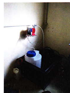
Le distributeur d'hypochlorite de soude.
