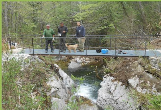
Les culées de l'ouvrage ont été maçonnées avec des pierres récupérées sur place, le tablier composé de 3 rails est recouvert d'un caillebotis en acier zingué d'une longueur de 8 m et de 1,20 m de large. Après les passerelles de Can Palat (également réalisées par les employés communaux), randonneurs et riverains peuvent désormais apprécier cet itinéraire en toute sécurité.
